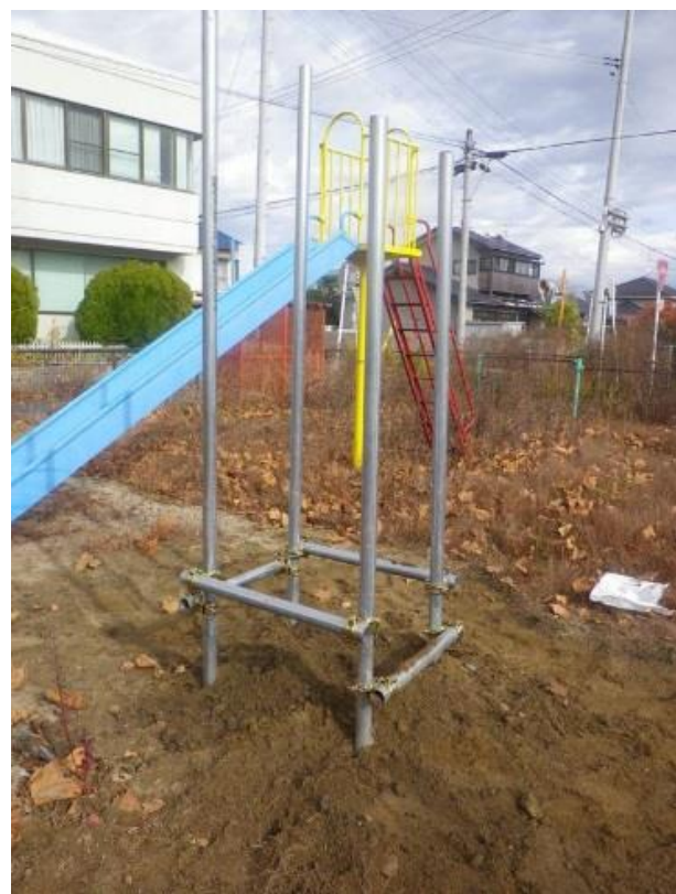
写真6 公園内設置工事
